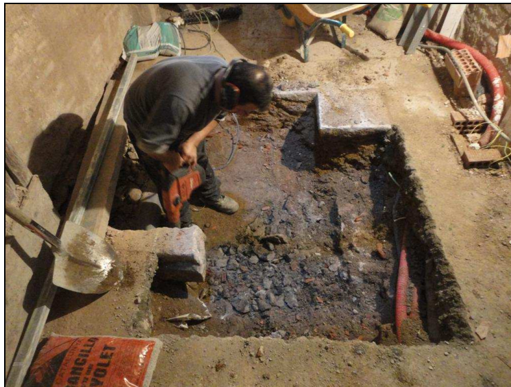
Treballs de rebaix manual al Rebaix 100
